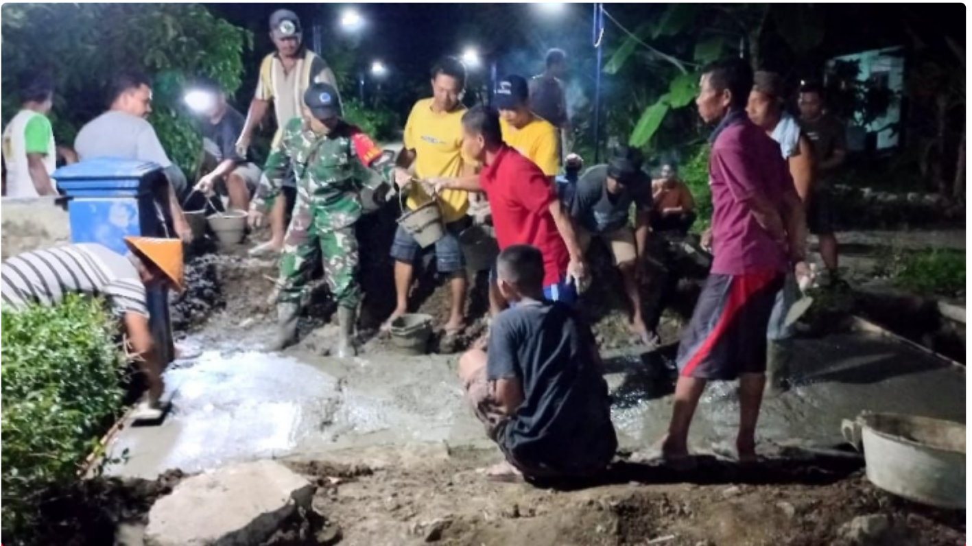
Babinsa Koramil 19/ Kuwarasan Bantu Pengecoran Jembatan Di Desa Binaan
