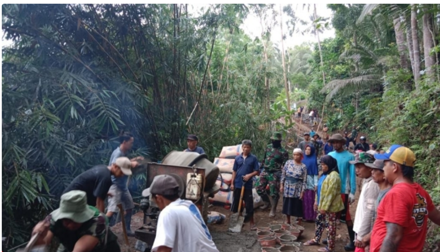
Babinsa Koramil 22/Ayah Serma Tugino bersama warga Giyanti bahu membahu membangun talud penahan bahu jalan
